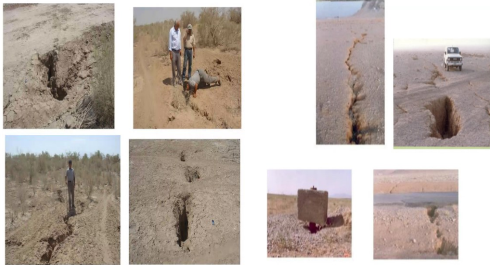
ایجاد شکافهای ناشی از فرونشست زمین در دشت اردستان
