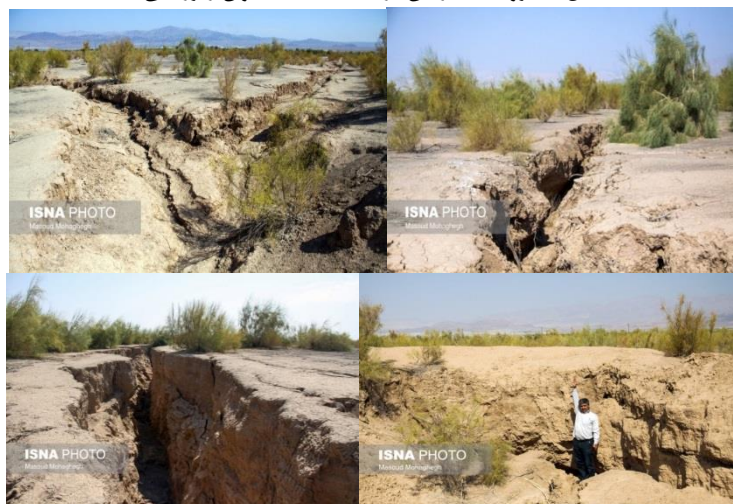
شکل ۵: فرونشست زمین در نتیجه افت آبخوان زیرزمینی
