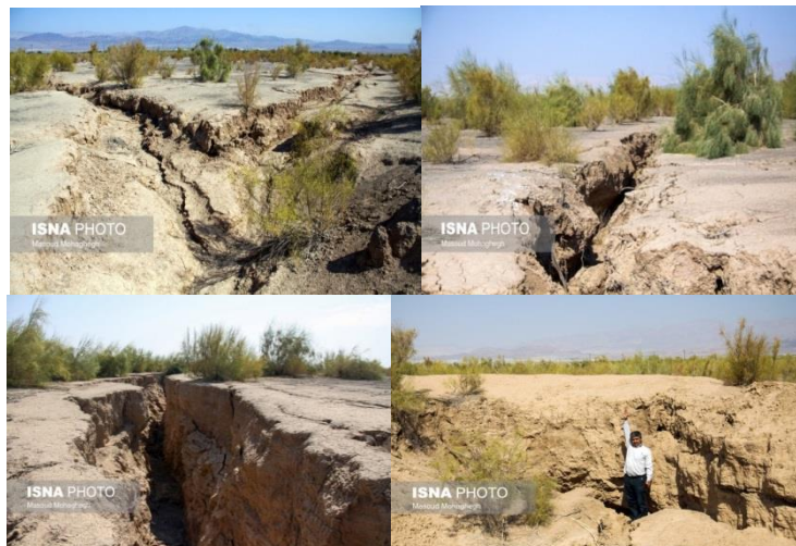
شکل ۵: فرونشست زمین در نتیجه افت آبخوان زیرزمینی
